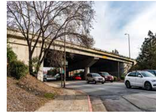
Underpass on el Camino real
